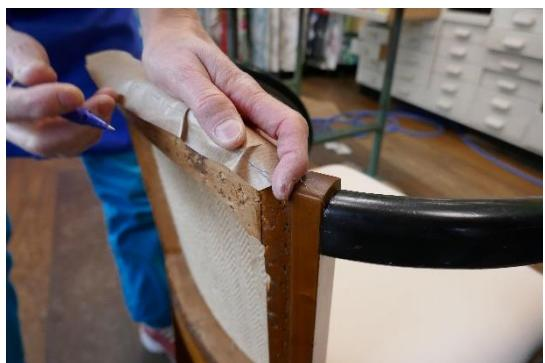
2. Papiermuster für die Schaumstoffauflage erstellen, Schaumstoff (RG 30) zuschneiden, Jutetuch und Schaumstoff mit Kontaktkleber bestreichen, antrocknen lassen, zusammenkleben, Kanten auch wieder in Rundung kleben.
